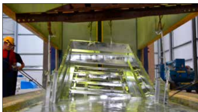
Thermisch verzinkingsbad (galvanisatie aan binnen- en buitenzijde)
